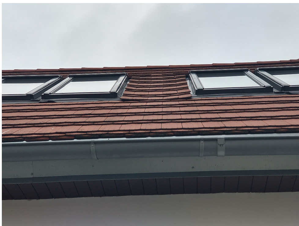
fot. 2. Pokrycie dachu. Widoczne podniesienia dachówek przy oknach dachowych.
