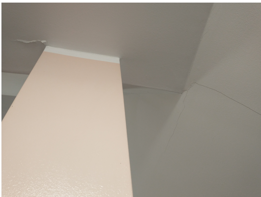
fot. 13. Rysy na stykach płyt gipsowo-kartonowych
